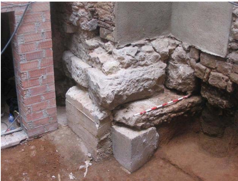
FOTO 7. Vista final de l'aqüeducte
