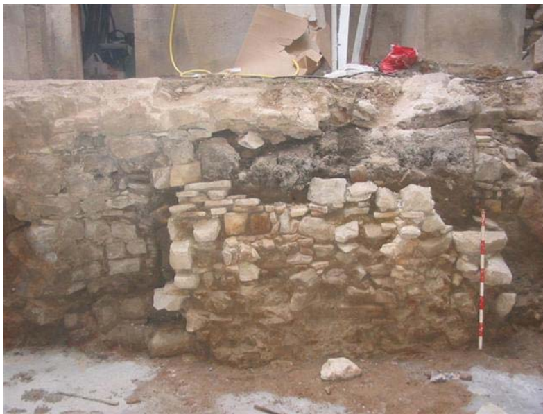
FOTO 4. Vista de l'estructura UE: 123.
